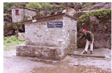
600m水道引込みと貯水槽
