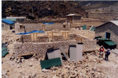
建設中の学生寮
