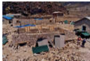
2002.5 建設中の MHC 学生寮
