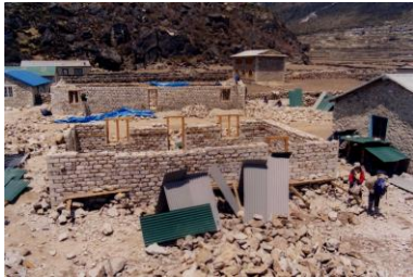
建設中の学生寮
