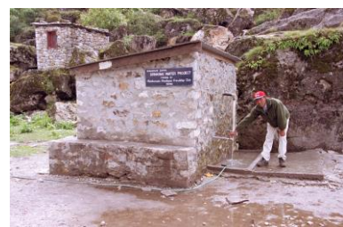
600m水道引込みと貯水槽
