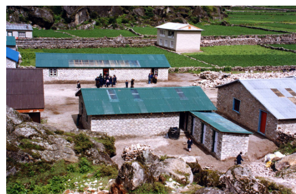
完成した MHC 学生寮
