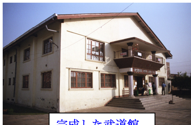
完成した武道館
