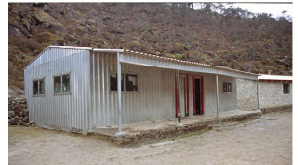
1960年建設したアルミニウム性校舎
