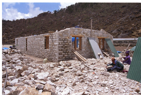
建設中の MHC 学生寮
