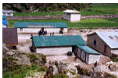
完成した MHC 学生寮
