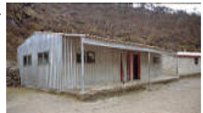
1960 年建設したアルミニウム性校舎
