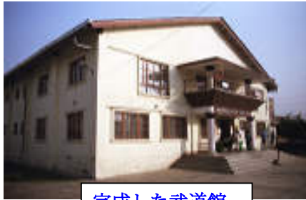
完成した武道館
