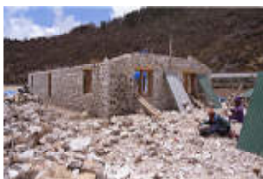
建設中の MHC 学生寮
