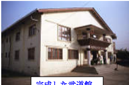
完成した武道館
