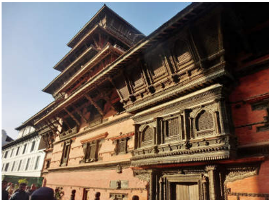
旧王宮最大級の建物、バサンプールバワン、震災で倒壊していたが、完全に復興建造された。木造、9階建、高さ31m、最上階の窓から、カトマンズ市街を、望むことができる。この周辺は旧王宮ダーバースクエアと呼ばれ、世界文化遺産に登録。
