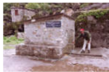
600m水道引込みと貯水槽
