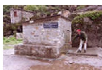
600m水道引込みと貯水槽
