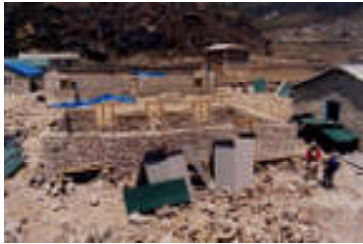
建設中の学生寮
